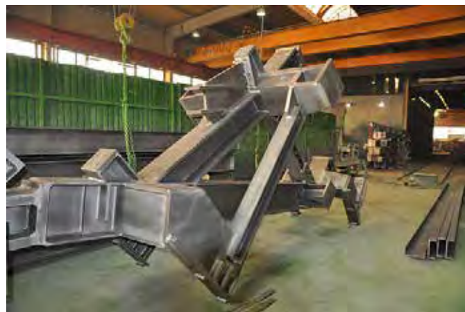
Bild 18. Fertigung einer Primärstahlrippe bei HASLINGER Stahlbau GmbH (© 2014, HOCHTIEF, Robert Schymalla)
