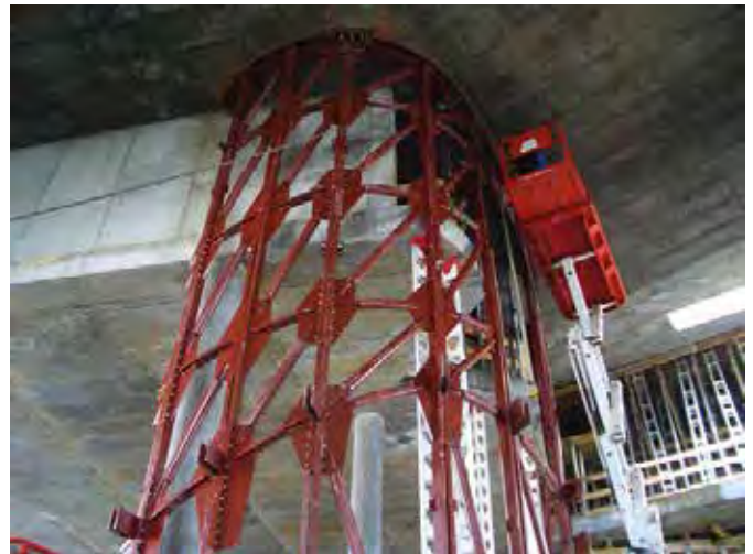
Bild 23. Montage große Foyertreppe (© 2014, HOCHTIEF) Fig. 23. Erection of the great foyer staircase
