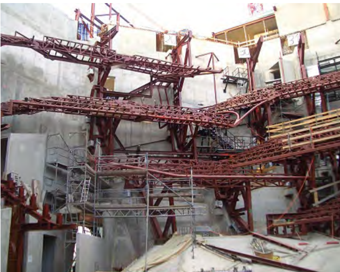
Bild 19. Stahlbau der Balkone (© 2014, HOCHTIEF, Robert Schymalla)
