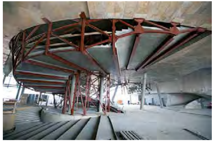
Bild 22. Große Foyertreppe im Rohbau (© 2014, HOCHTIEF) Fig. 22. Great foyer staircase before finishing works
