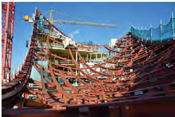
Bild 5. Dachflächen mit Grat- und Randträgern (© 2014, HOCHTIEF)
