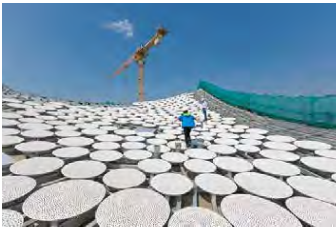
Bild 8. Fertiggestellte Dachfläche mit Paillettenbekleidung (© 2014, HOCHTIEF)
