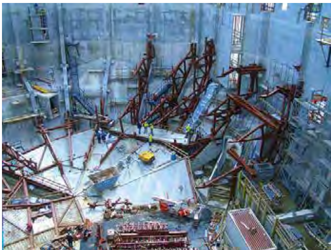
Bild 16. Erste Stahlbaumontage Saaltopf-Innenschale (© 2014, HOCHTIEF)
