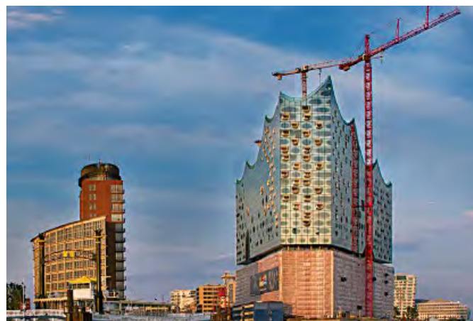
Bild 1. Elbphilharmonie Gesamtgebäude (© Verena Meier) Fig. 1. Elbphilharmonie complete building
